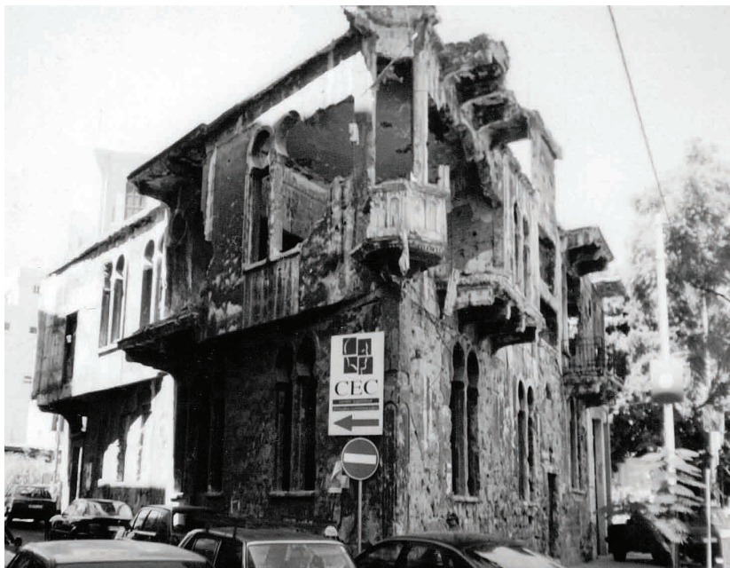
Rys. 4. Bejrut, rok 2003, budynek zniszczony podczas wojny domowej w latach 1975-1992, fot. Aleksandra Dzisiów-Szuszczukiewicz
